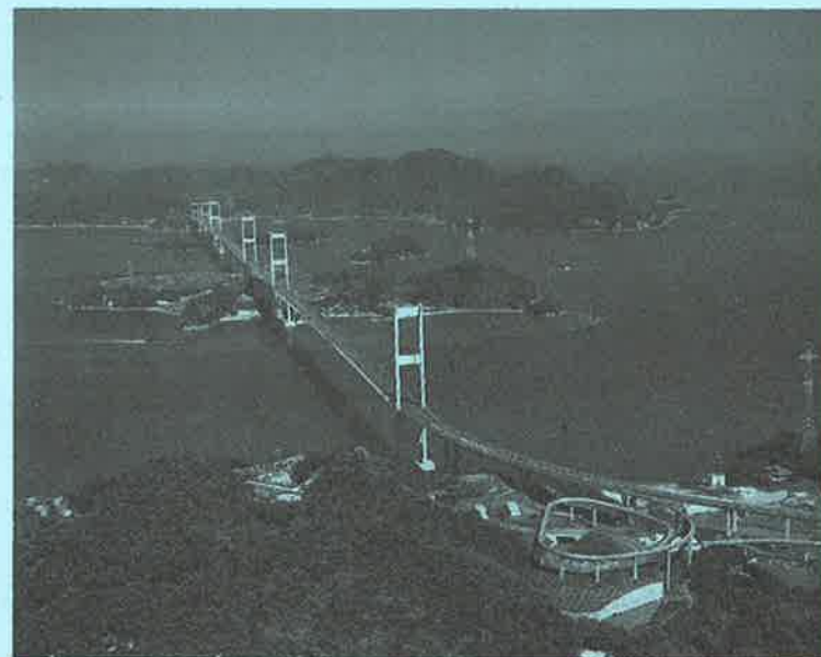
世界初の三連吊り橋 来島海峡大橋
