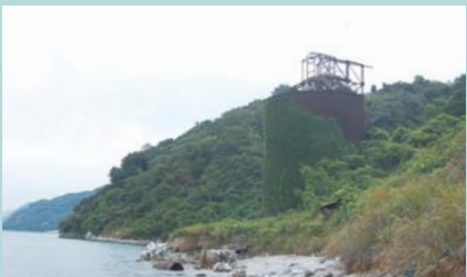
② 石灰石貯蔵タンク ※高さ約15m 本村上鉦山の崖壁に設置された石灰石貯蔵タンク(2,300t収納)。昭和9年に日東セメント(株)が設置するも、同16年に同鉦山は浅野セメント(株)の傘下となる。昭和52年に閉山。
