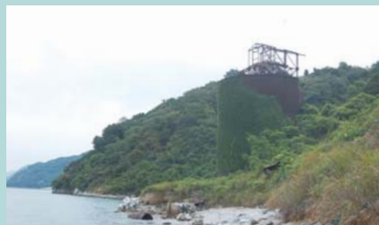
② 石灰石貯蔵タンク ※高さ約15m 本村上鉦山の岸壁に設置された石灰石貯蔵タンク(2,300t収納)。昭和9年に日東セメント(株)が設置するも、同16年に同鉦山は浅野セメント(株)の傘下となる。昭和52年に閉山。
