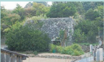
④ 石灰窯 ※幅約10m、高さ約5m 肥料用石灰を焼成するための窯で、焚き口は2つあり、内部は徳利状の耐火煉瓦構造をしている。大正～昭和初期の築造か。こうした窯跡が、島内にはまだ数基残っている。
