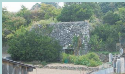
④ 石灰窯 ※幅約10m、高さ約5m 肥料用石灰を焼成するための窯で、焚き口は2つあり、内部は徳利状の耐火煉瓦構造をしている。大正～昭和初期の築造か。こうした窯跡が、島内にはまだ数基残っている。
