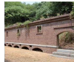
弾薬庫跡 (床下アーチの構造は、防湿目的)
